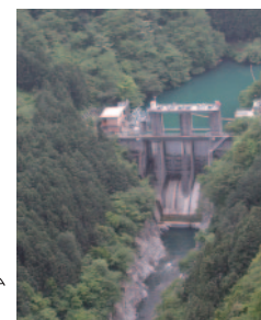
奥多摩町にある白丸発電所のダム
