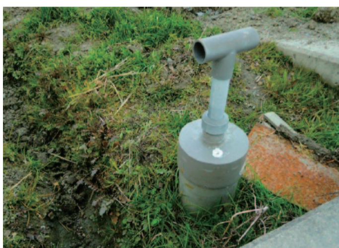
西条は石鎚山の伏流水を飲料とする等、水が美しく、豊富なところ。だからこそ実践できる先進農業。この装置で水をくみ上げ、飲料水と同じ水質の水を農業用に使い、レタスを育てています。つまり、美しくおいしい飲み水で育てたレタスです。
