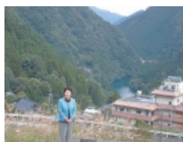
元祖・自然エネルギー『水力発電』。眼下に多摩川の白丸ダム(2016年10月)
